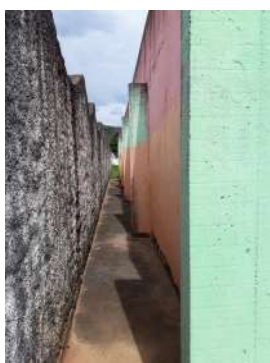
Imagem 2- Parte anterior a arquibancada A. Na esquerda verifica-se o muro existente a demolir.
