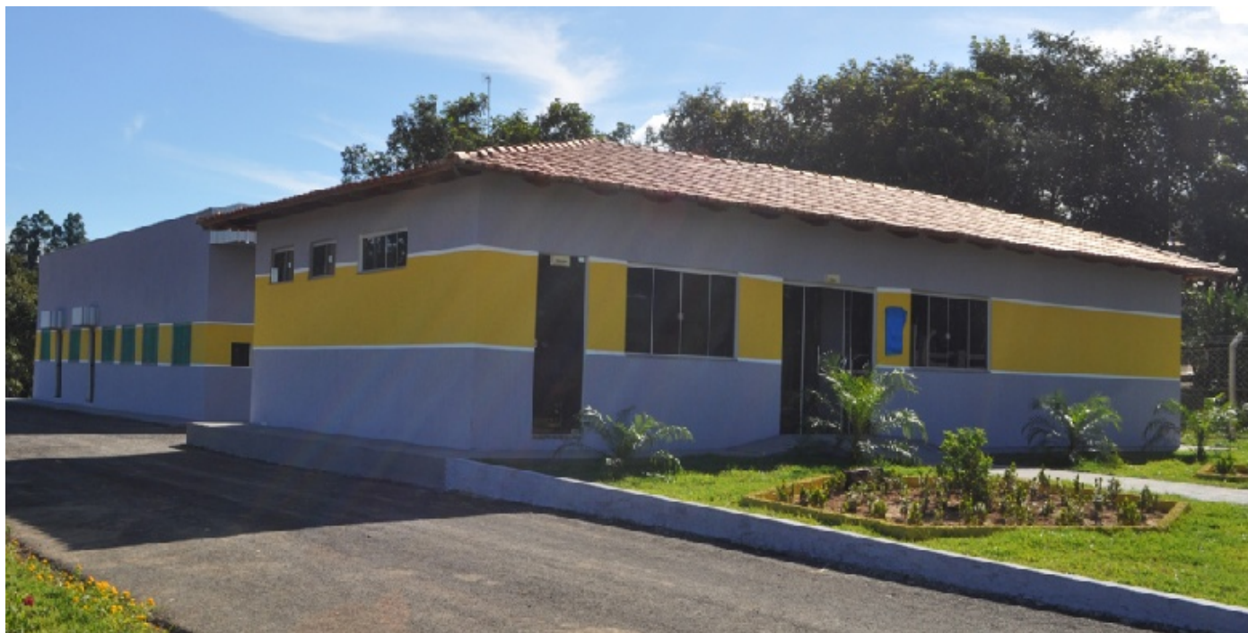
Figura 3 - Vista da unidade administrativa e de processamento.
